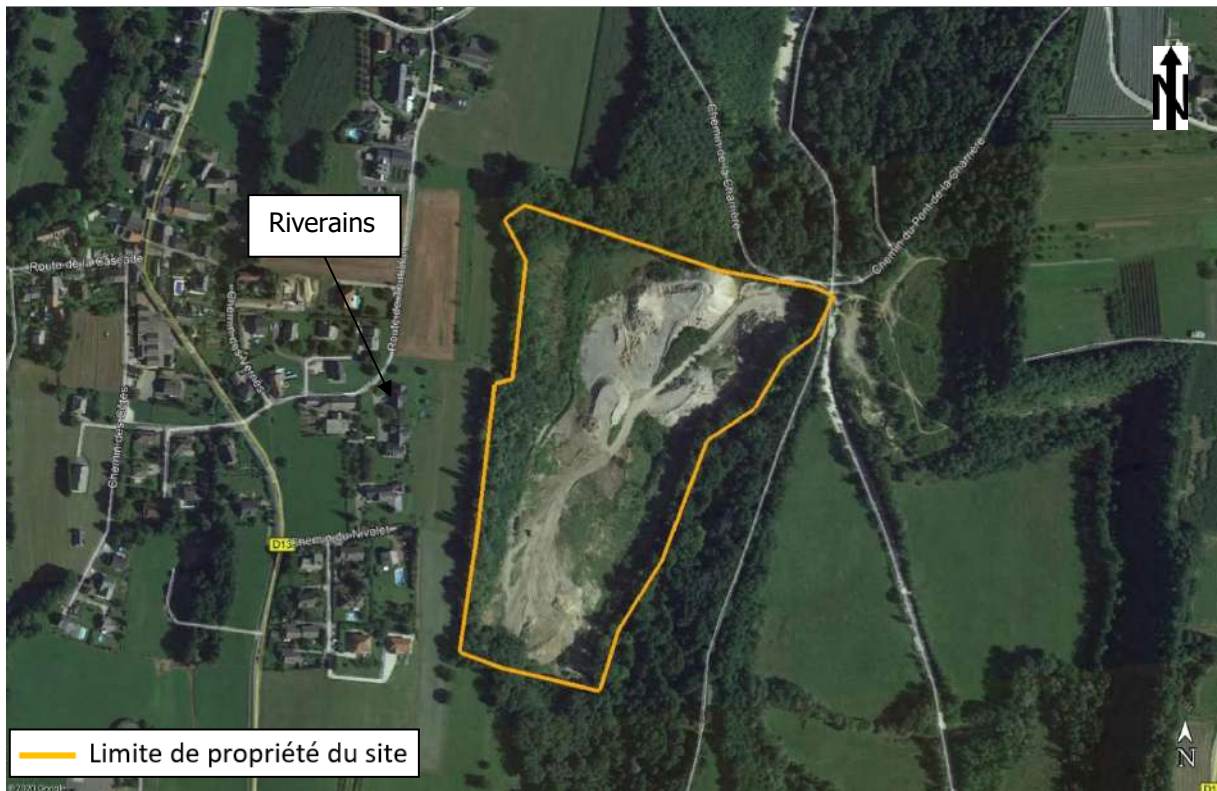
Figure 1 : Vue aérienne du site et de son environnement 2
