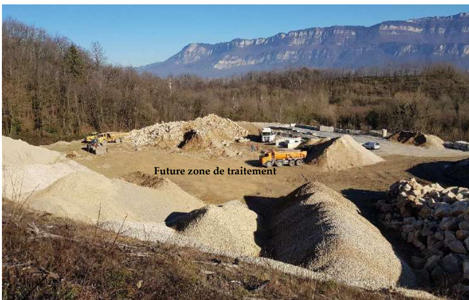
Photographie 4 : illustration de la zone d'accueil des futures installations
